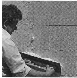
Abb. 2.4.4-2 Auftrag des Grundputzes von Hand
